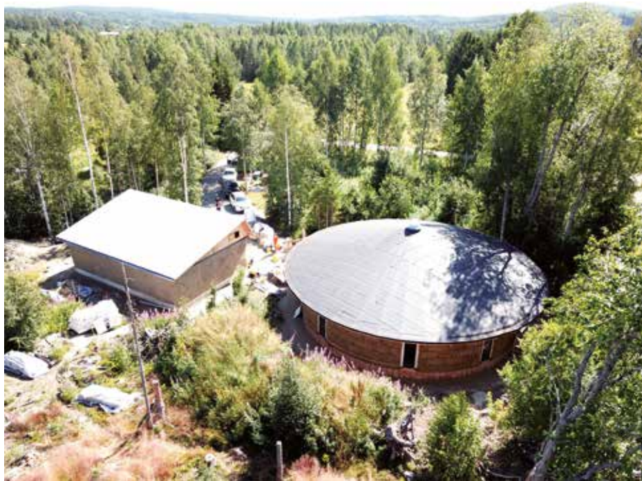
Rundbalshuset uppförs i Kassjö, 2 mil från centrum i Umeå.
